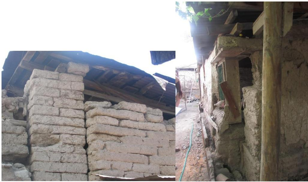
La vivienda consta con una base estructura de madera, la cual ordena los muros de adobe, y en el techo se aprecia una pendiente mínima, con un alero pequeño, el cual afecta de forma negativa a la casa, ya que la lluvia puede impactar de forma más directa y la deteriora con mayor rapidez.
